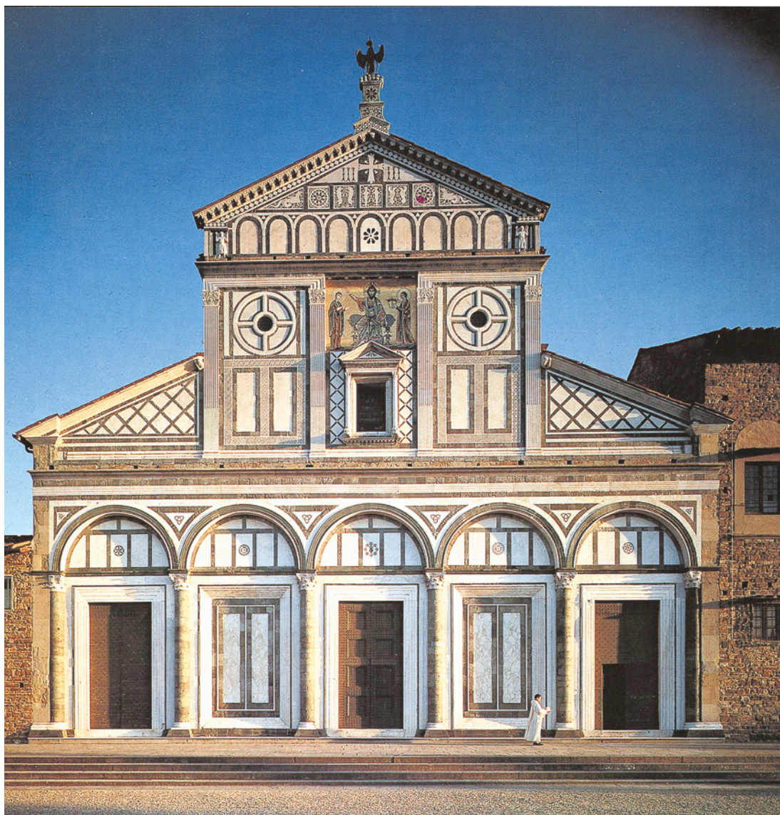
FIG. 2 Facciata della Chiesa di San Miniato, Firenze
